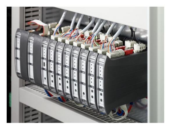
Notstromsteuerzentrale für RWA-Antriebe mit einer Gesamtstromaufnahme von 8 A bis 72 A
